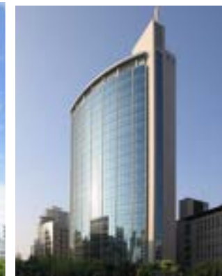
5. 江戸堀センタービル 9階
