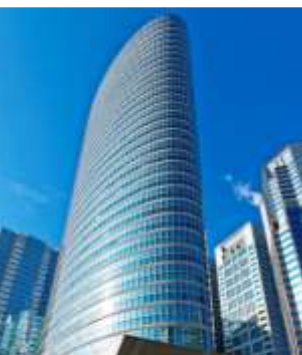
13.品川インターシティA棟 28階
