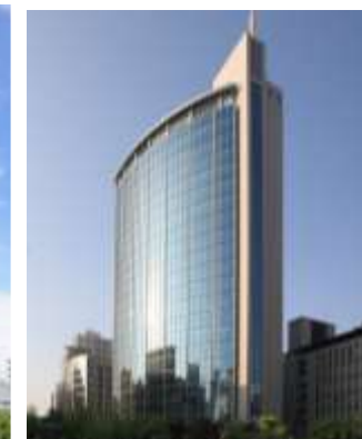
5. 江戸堀センタービル 9階
